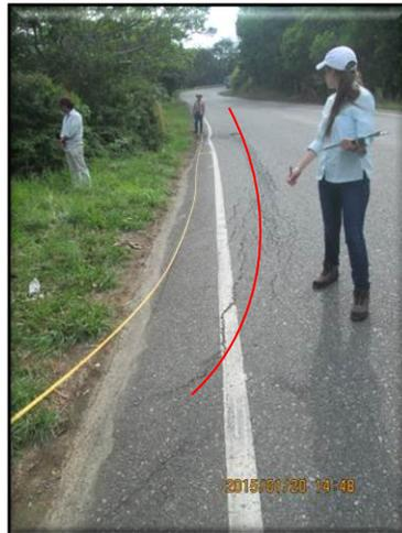
Fotografía 11 Deslizamiento de rotación del terraplén
