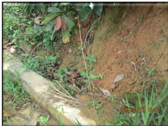
Fotografía 5 Taponamiento de la obra de drenaje transversal
