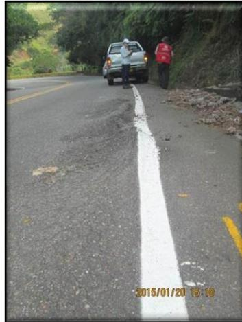
Fotografía 13 Levantamiento de la superficie de rodadura K 72+850
