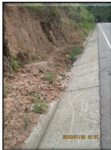
Fotografía 10 Estado de la cuneta existente EN k49+600
