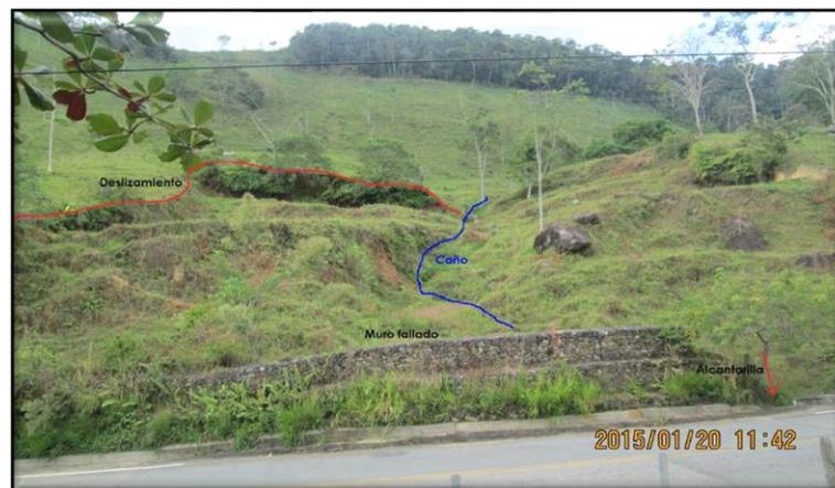
Fotografía 6 Contorno del deslizamiento, caño, muro fallado y alcantarilla
