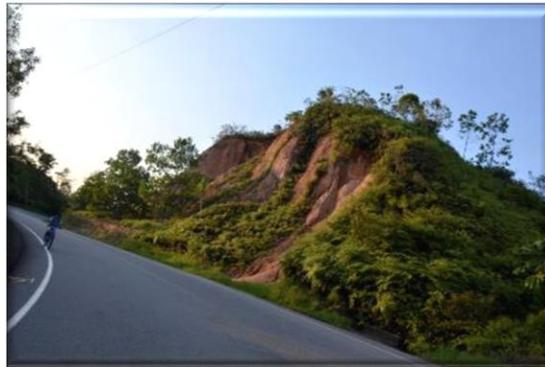
Fotografía 23 Taludes elevados y erosionados en inmediaciones de La Floresta, se encuentran entre los kilómetros 53 y 50, municipio de Maceo.
