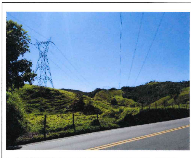
Registro 2. Servidumbre eléctrica
