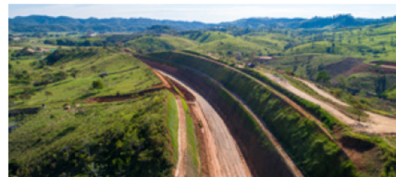
Entre Vegachí y Alto de Dolores en Maceo, se construye la Unidad Funcional 2, vía nueva que forma parte del proyecto Autopista Río Magdalena.
