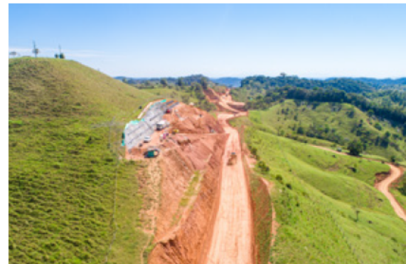
Con movimiento de tierras, como las excavaciones para adecuación del terreno, estabilización de taludes y obras de drenaje, entre otras, avanza a paso firme la construcción de la Unidad Funcional 1.
