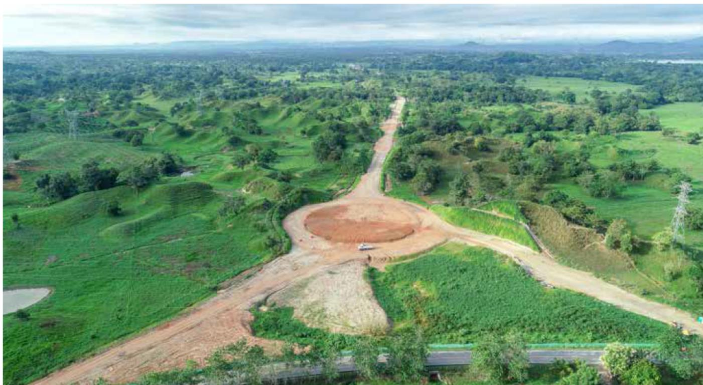
En la variante de Puerto Berrío, que forma parte de la UF4, se realiza la construcción de terraplenes, pedraplén y obras de drenaje.
