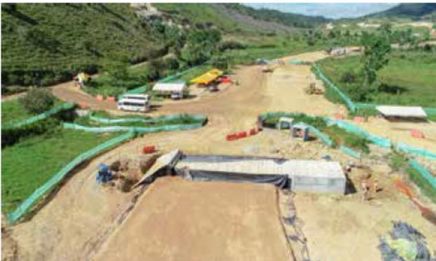
*Construcción de terraplenes, obras de drenaje y estabilización de taludes son algunos de los trabajos que ejecuta la Autopista al Río Magdalena 2 en inmediaciones del municipio de Vegachí.*
