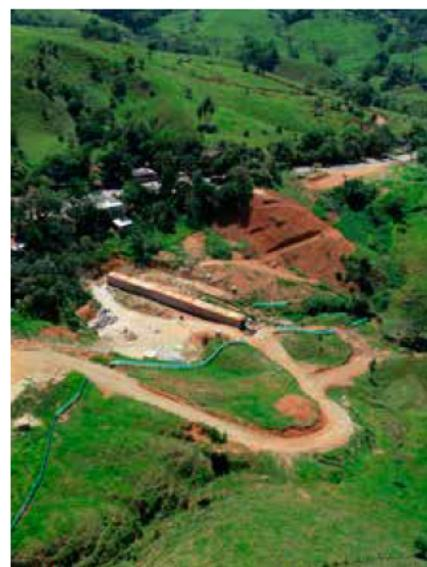
En el sector de La Carlota, correspondiente a la UF3, se construyen obras de drenaje y se realiza el descapote de la capa vegetal y excavaciones, entre otras actividades.
