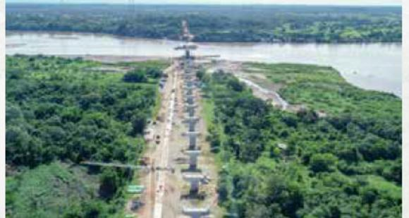
Con la instalación de prelosas, acondicionamiento de pilotes, instalación de vigas, cartelas, arcos de chapa, apoyos provisionales y vigas prefabricadas, Autopista Río Magdalena continúa la construcción del puente sobre el río Magdalena.
