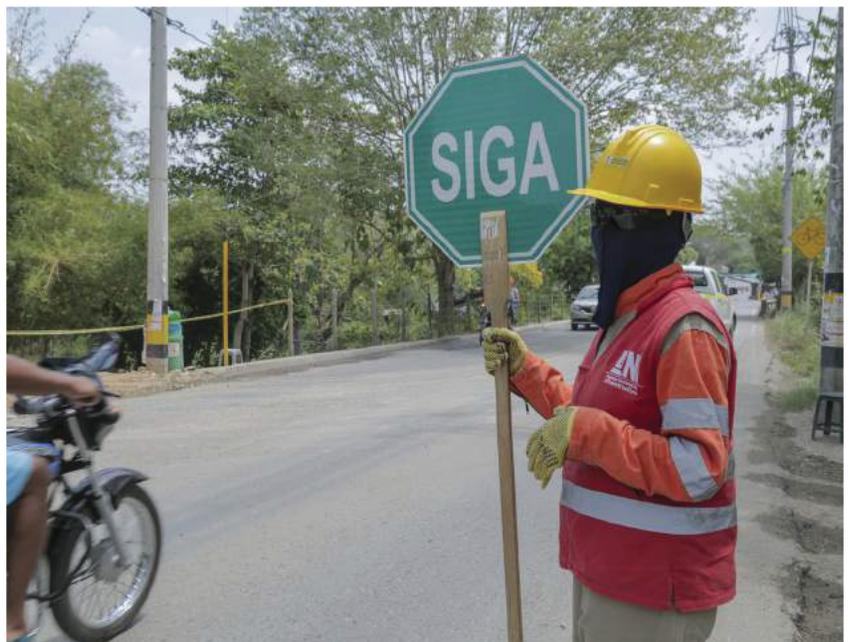
Cuando el palettero cambia la señal de PARE a SIGA, el conductor puede continuar la marcha con precaución, para no afectar la obra y propiciar su seguridad y la de los trabajadores.
