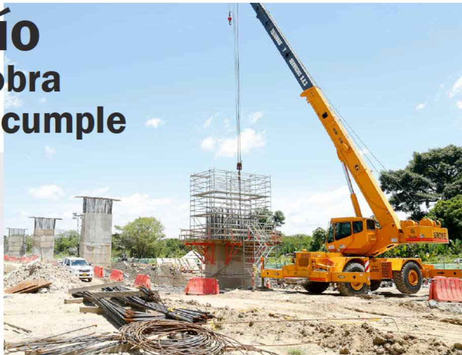
**Con el anclaje de las pilas, pilotes y otras obras, avanza a buen ritmo la construcción del nuevo puente sobre el río Magdalena y la variante de Puerto Berrío.**
