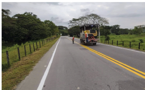
Con restauración en la pintura de la demarcación horizontal y el cambio de tachas dañadas, Autopista Río Magdalena garantiza la movilidad segura de los usuarios de la vía.
