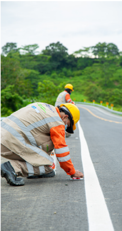
Las tachas son dispositivos elevados anclados al pavimento, que hacen parte de la demarcación horizontal para regular el tráfico vehicular.
