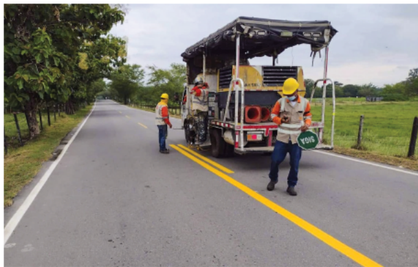
Con restauración en la pintura de la demarcación horizontal y el cambio de tachas dañadas, Autopista Río Magdalena garantiza la movilidad segura de los usuarios de la vía.
