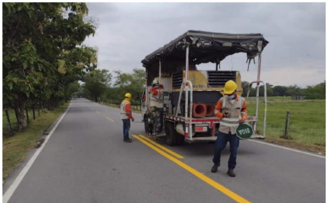
*La señalización horizontal permite a los conductores recibir información del estado de la carretera y de la ruta a seguir, sin retirar la visión del pavimento.*
