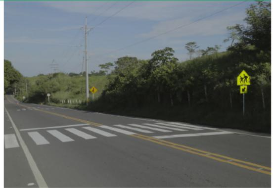
Estas señales se delinear con pintura de colores amarillo y blanco que contiene microesferas que, al contacto con la luz de los vehículos, producen la reflectividad que permite a los usuarios ver e identificar el tipo de señalización, especialmente en horas nocturnas.
