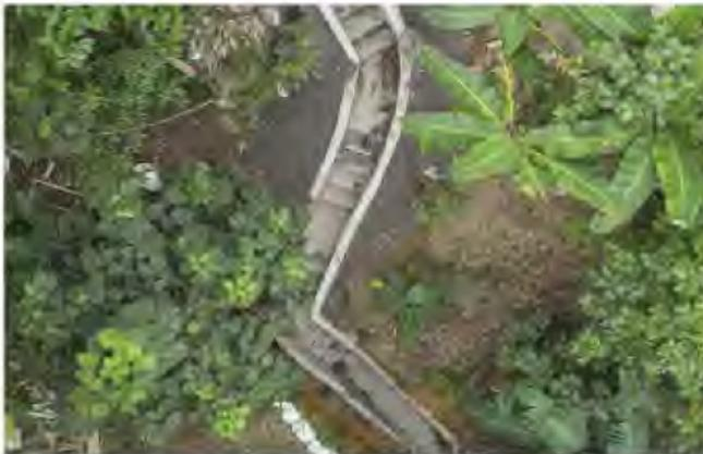
Adicionalmente, se construyó un dissipador de energía, que corresponde a una estructura hidráulica diseñada para transportar un caudal de agua en cantidad superior manteniendo la velocidad (energía cinética) dentro de límites permisibles, con el fin de evitar procesos erosivos en la caída y en el cauce receptor, y la posible falla de la estructura misma.
