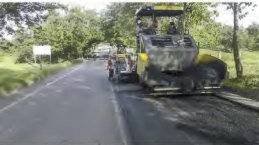
**Las actividades de mantenimiento de la Autopista Río Magdalena incluyó el sellado de fisuras, parcheo técnico, reparación del pavimento desgastado e instalación de carpeta asfáltica.**
