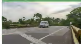
Puente Ferrocarril, ubicado en el PR 103+900.
