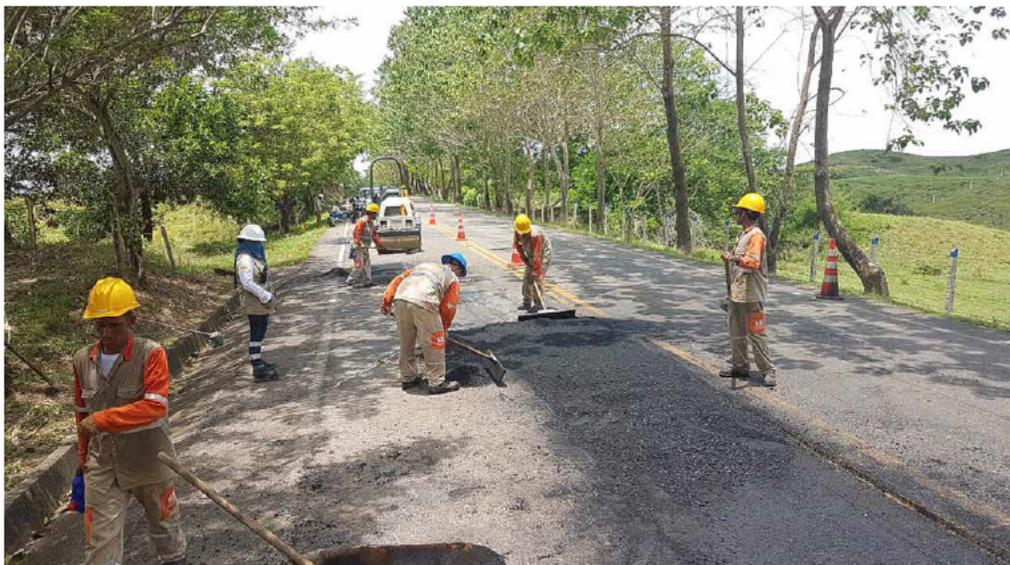
La adecuada reparación que Autopista Río Magdalena realiza a la carpeta asfáltica, permite mantener la vía libre de huecos y baches, para brindar seguridad a conductores y demás usuarios al momento de desplazarse por el corredor vial.
