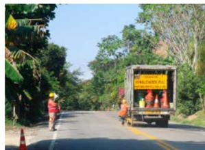
*A través del uso de un vehículo especial se realiza la demarcación horizontal de la vía.*
