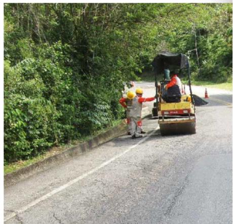
En el PR 109+380 de la Autopista Río Magdalena, correspondiente al municipio de Cimitarra -Santander, se realizaron trabajos de mantenimiento correctivo del pavimento, los cuales incluyeron, entre otros, la construcción de filtros y reposición completa de la estructura del pavimento.
