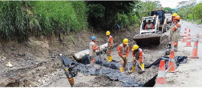
Trabajos de estabilización de la subrasante y construcción de filtros en la Autopista Río Magdalena, para seguridad y comodidad de los usuarios del corredor vial.
