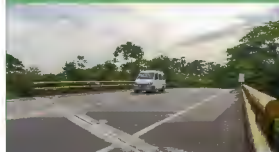
Puente Ferrocarril, ubicado en el PR 103+900.
